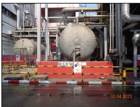
ภาพที่ 2.2-37 คั่นกันรอบถังเก็บ Fuel Oil Daily Tank
