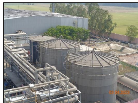
ภาพที่ 2.2-31 ระบบสเปรย์น้ำรอบถังเก็บ EG
