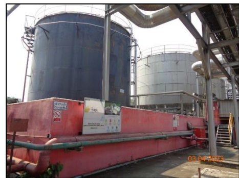
ภาพที่ 2.2-36 คั่นกันรอบถังเก็บ Fuel Oil
