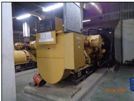
ภาพที่ 2.2-9 Silencer ของเครื่อง Diesel Generator
